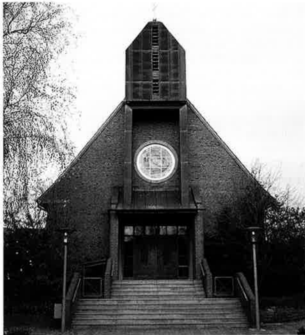
Abb. 2: Das kirchliche Gemeindezentrum Albert-Schweitzer-Haus, errichtet 1957, mit späteren baulichen Veränderungen (Foto 2004)
