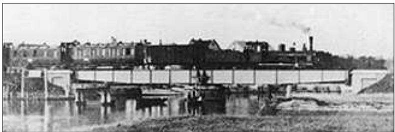
Im Zuge des Marschbahnbaus musste der Husumer Binnenhafen 1887 mit einer 34 Meter langen Brücke überquert werden.
