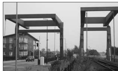
Links die 2001 im Rahmen der Westtangente für den Verkehr freigegebene Autobridge über den Hafen, rechts die 1979 gebaute eingleisige Waagebalkenbrücke der Bahn, sie ersetzte die alte, seit 1963 eingleisige Klappbrücke.
