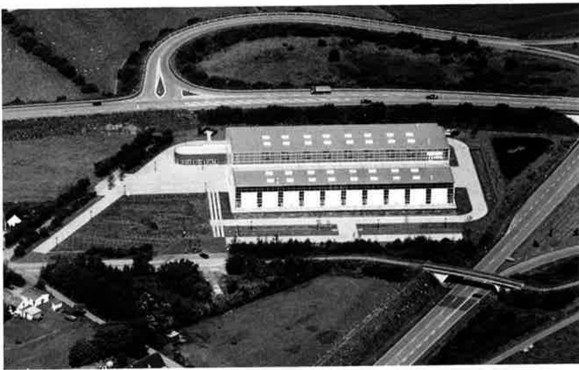
Abb. 3: Die Messehalle Husum, offiziell eingeweiht am 17. September 1997, liegt bei Kielsburg im Dreieck zwischen Umgehungsstraße (B 5) und Flensburger Chaussee (B 200). Für diese Multifunktionshalle aus Stahl, Glas und Beton wurden rd. 13 Mio. Mark aufgewendet, von denen 85 % aus EU-Mitteln und vom Land Schleswig-Holstein und die restlichen 15 % von der Stadt aufgebracht wurden. Wichtigste Veranstaltungen waren bis jetzt die Windenergiemesen „Husum Wind“ 1997 und 1998. Im Oktober 1998 legte die Husumer Wirtschaftsgesellschaft als Pächterin und Betreiberin ein Konzept zur stärkeren Nutzung der Halle vor. (Foto Dietrich)
