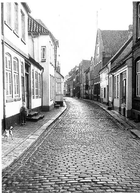
Abb. 5: Blick in die Wasserreihe (1956)
