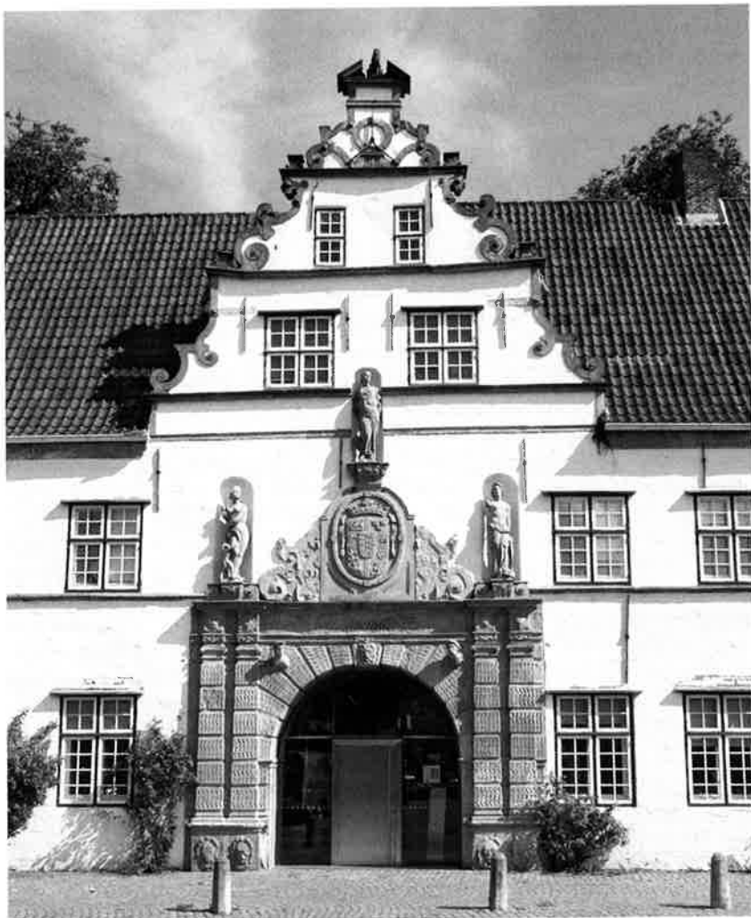
Abb. 4: Portal des Torhauses, 2006, nach Einbringung der Kopie der „Hera“-Figur in die Portalbekrönung
