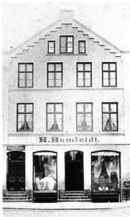
Abb. 2: Haus Markt 12 (Neubau v. 1871)
