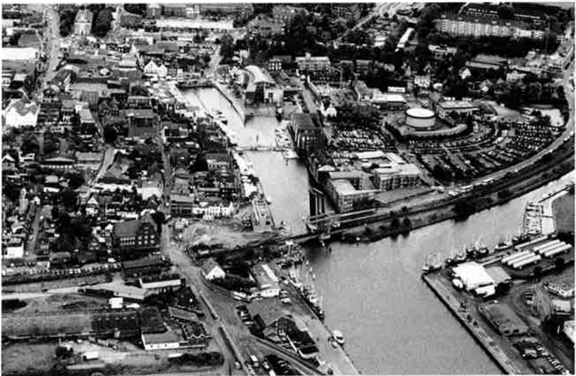
Abb. 6: Blick auf den Husumer Hafen von Westen im Jahre 2000. Die Straßenklappbrücke für die Westtangente ist schon fertig, aber noch nicht in Benutzung.
