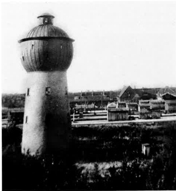
Abb. 6: Der Husumer Bahnhof vom Haus Ausborn in Rödemis aus gesehen (1946); der Wasserturm wurde später abgerissen.
